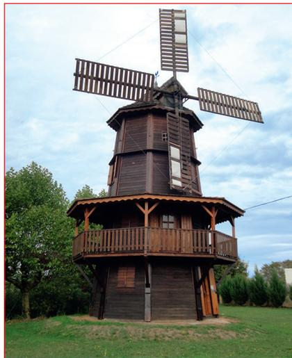
Un moulin à vent en bois de 16,50 m de haut, toiture pivotante sur 360°, meule qui broie le grain, tamis. Explication sur la création et la réalisation d'un moulin à vent en bois. Démonstration de la fabrication de la farine à la meule.
