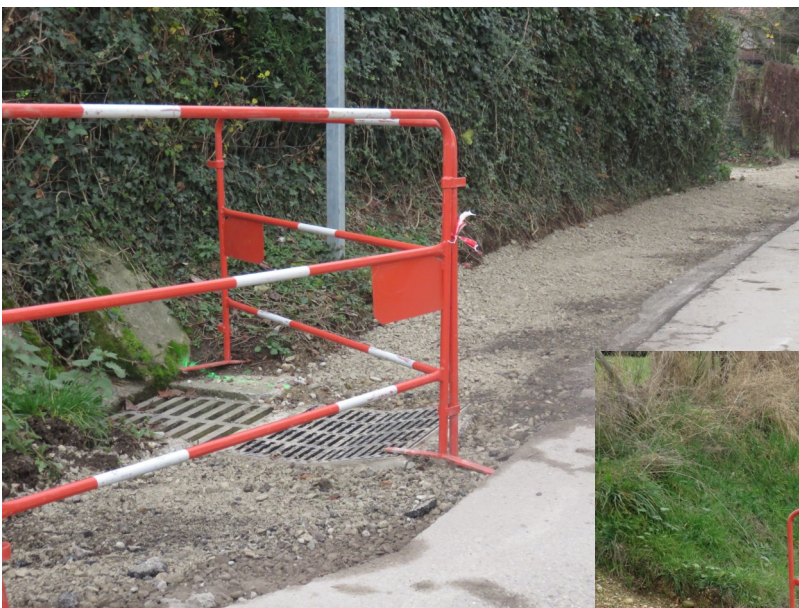
Préparation de la voirie avant la finition
