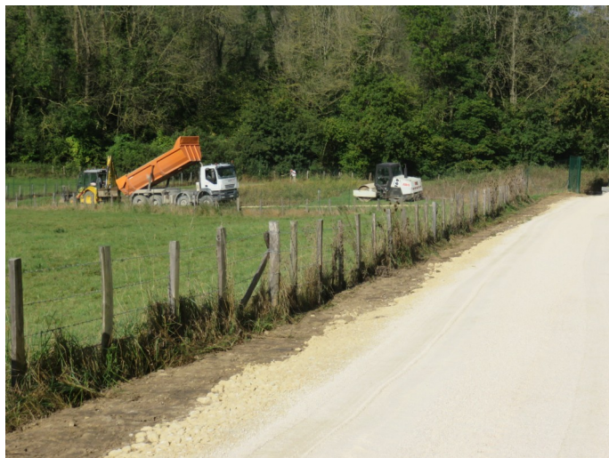
Le chemin d'accès après réfection
