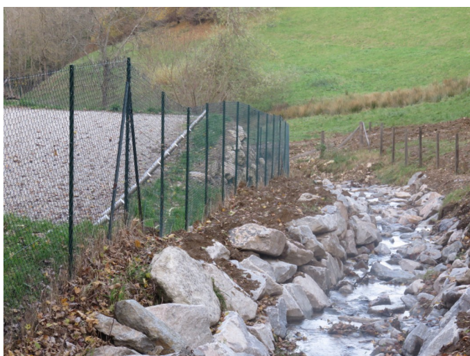
L'enrochement destiné à protéger la station par filtre à sable
