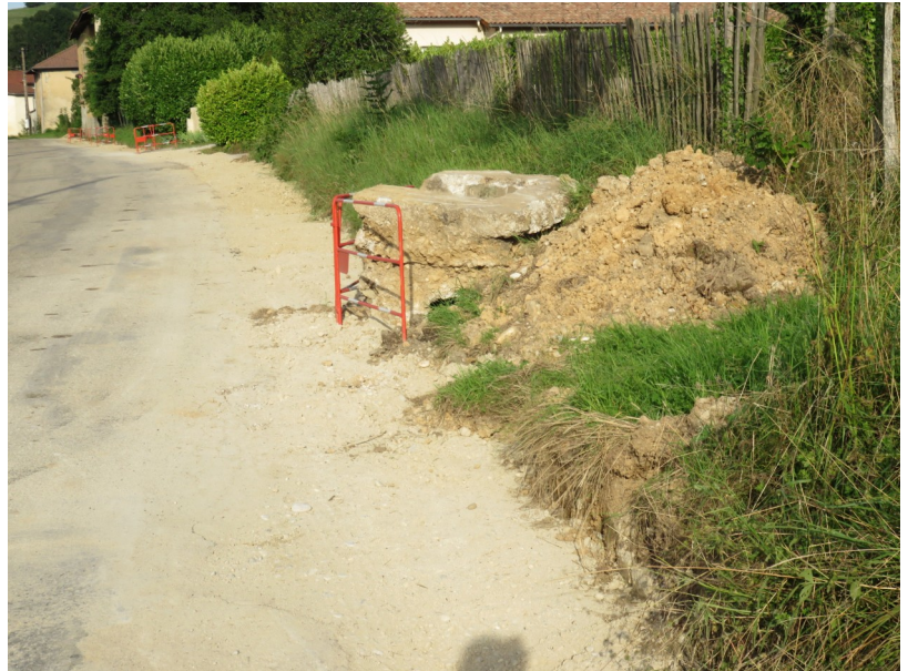
Les travaux de voirie suite à la pose des canalisations
