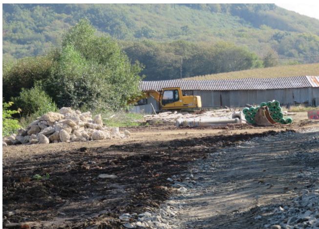
L'aire de stockage du chantier au départ de la piste
