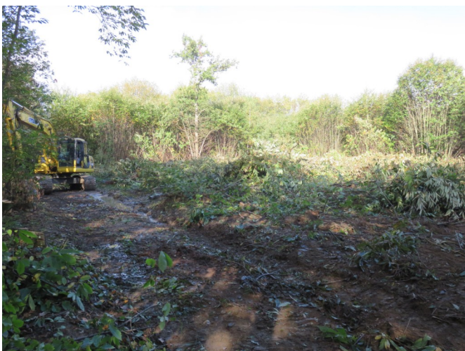
La piste avant travaux
