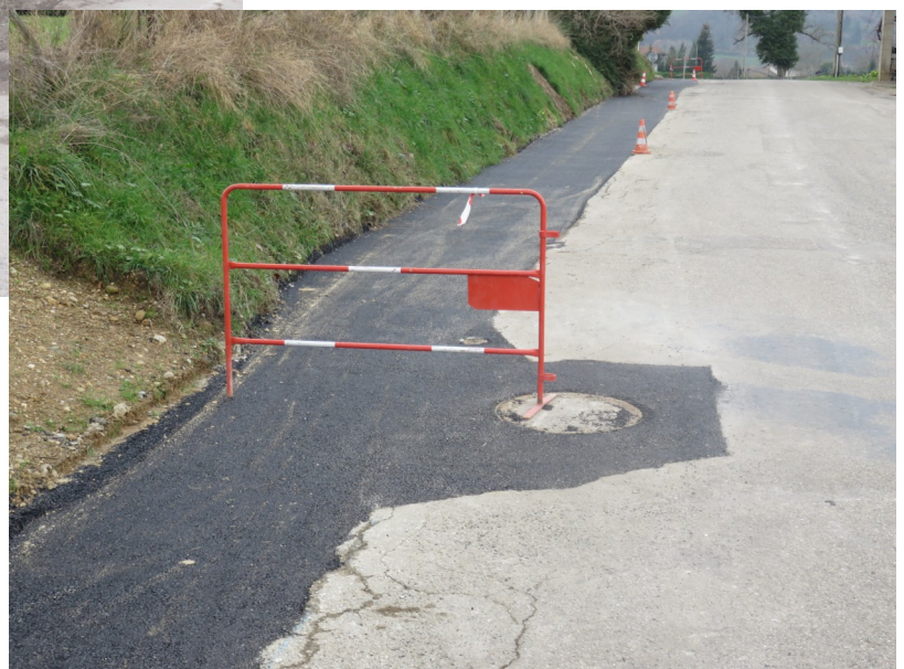
La chaussée après réfection
