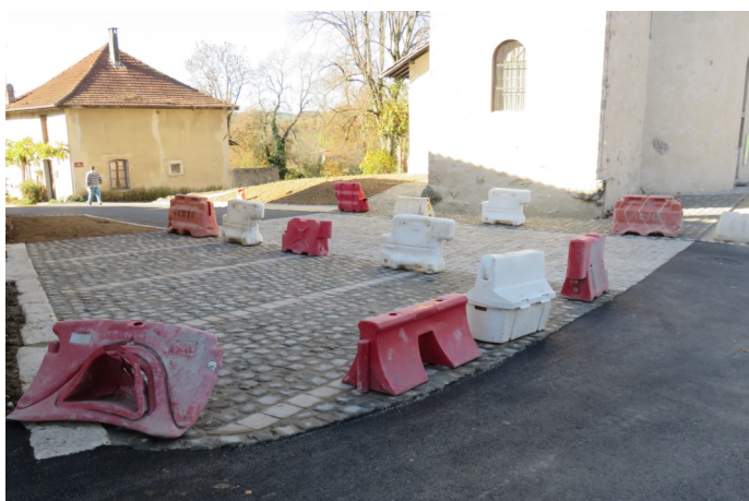
Les travaux en cours de réalisation
