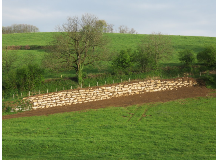
Le chemin de la Blache après l'enrochement
