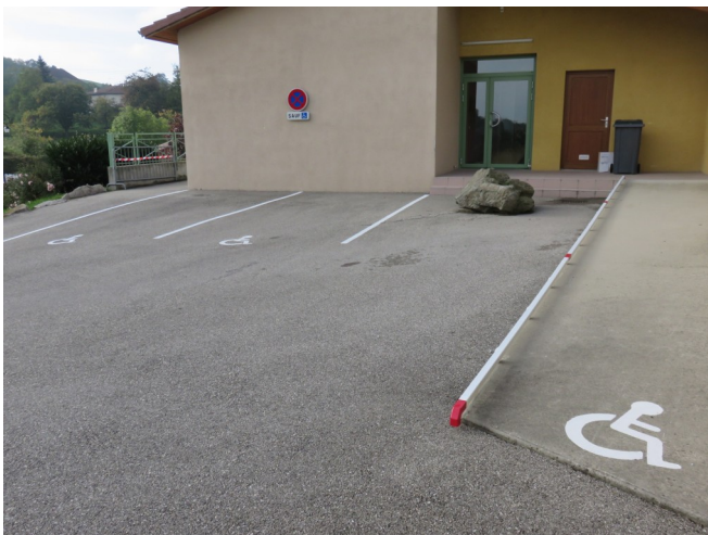
Places réservées et rampe d'accès à l'école
