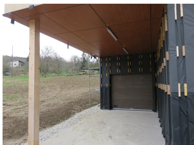
Mise en place des panneaux extérieurs
