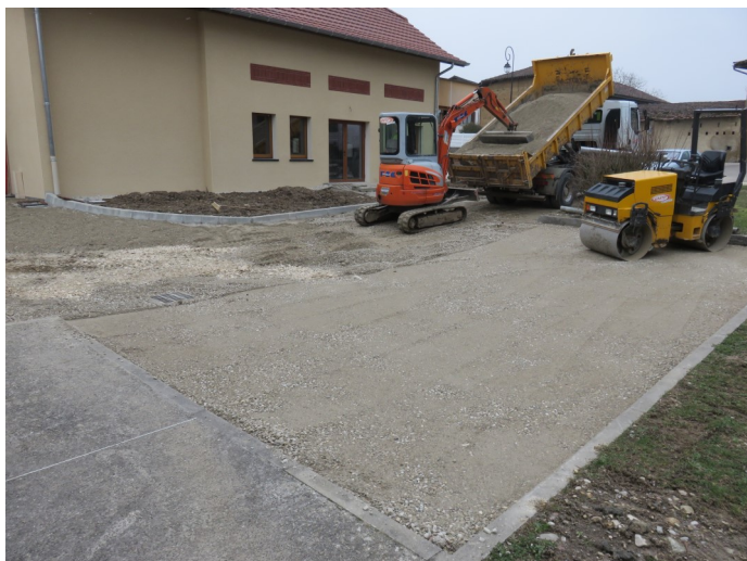
Préparation et réalisation des enrobés autour du bâtiment.
