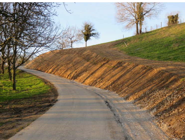
Étape après étape, les travaux prennent forme.
